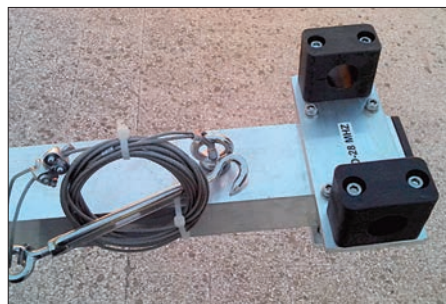
Bild 6: Halterplatte für die Stauff-Buchsen am 21-MHz-Reflektor – sehr stabil ausgeführt; auch gut erkennbar: die Abspannung.
