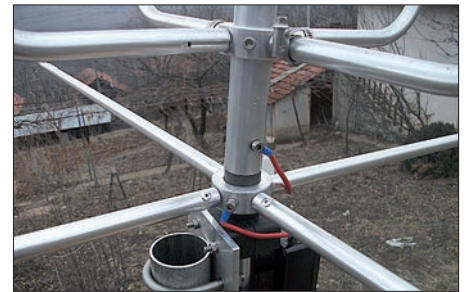
Bild 12: Befestigungen der Einzelstrahler am Fußpunkt der Vertikalantenne LZAV-5B und die Abstandshalter aus Kunststoff
